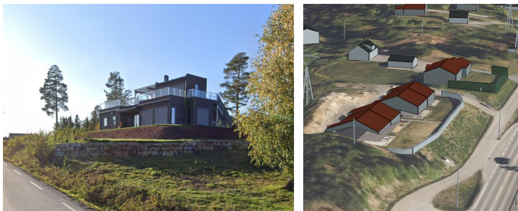
Fig. 14 og 15 viser bebyggelse som ikke er tilpasset terreng og topografi
