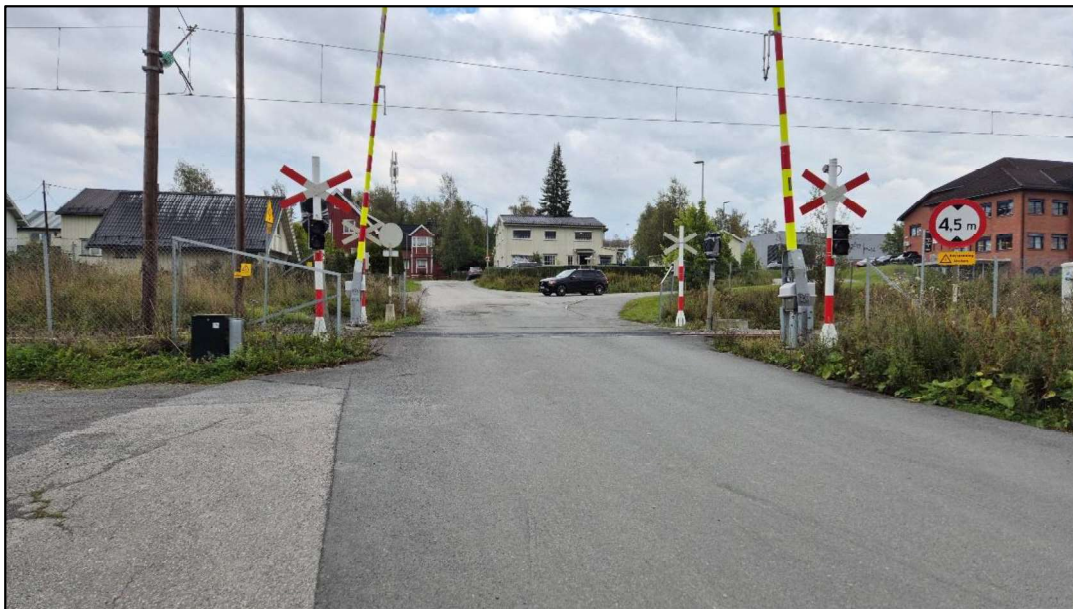
Figur 2-17: Korterudsvingen mot øst, sett fra rett ved planovergangen. Foto: Norconsult, 10.09.2025
