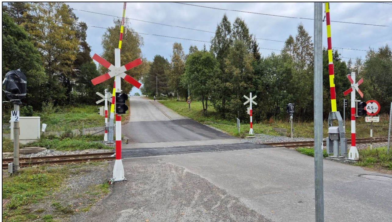
Figur 2-23: Løvåsbakken mot øst, sett fra krysset med Storgata. Foto: Norconsult, 10.09.2025
