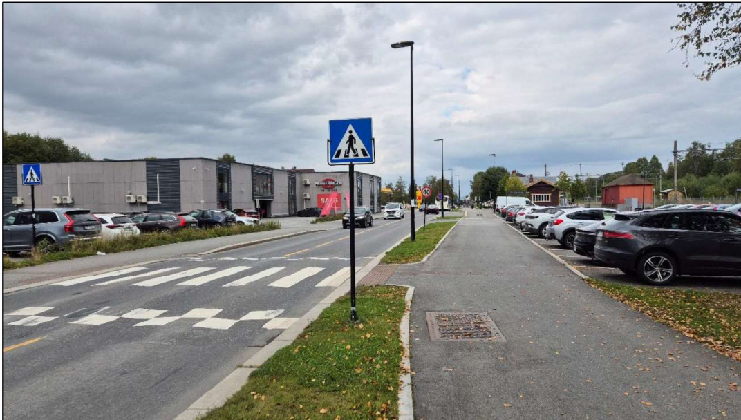
Figur 2-25: Fv2368 Storgata på strekningen sør for Raufoss stasjon. Foto: Norconsult, 10.09.2025
