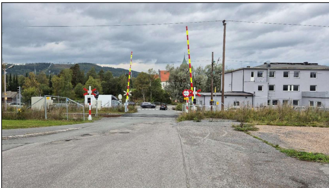
Figur 2-18: Korterudsvingen mot vest, sett fra krysset med Sigurd Østliens veg. Foto: Norconsult, 10.09.2025
