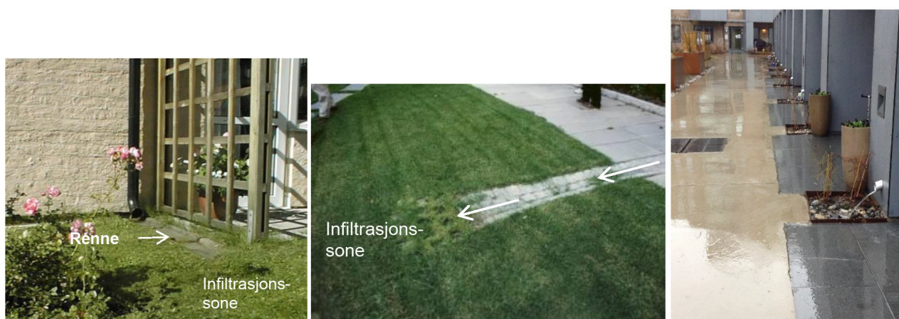
Figur 8. Bilder som viser eksempler på løsninger for utledning av takvann til infiltrasjon - trinn 1
