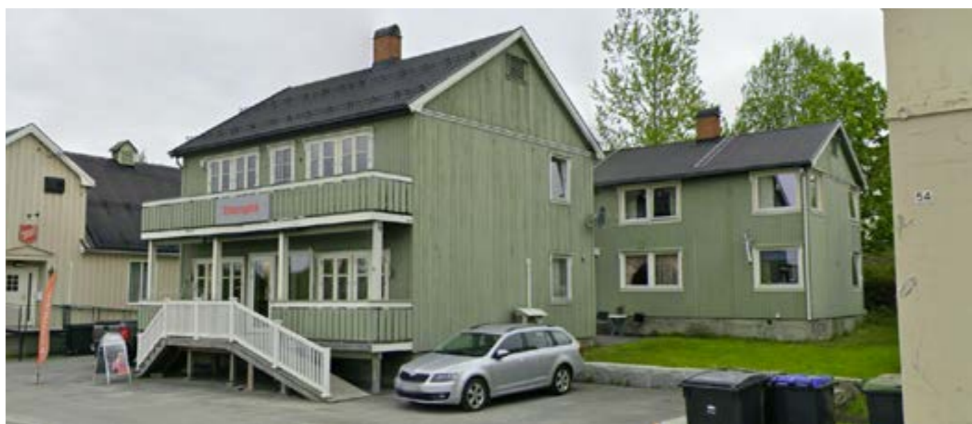
Figur 45: Storgata 56 – gbnr. 14/84. Bygget mot gata er yngst og oppført rundt 1938 og senere fasadeendret. Det bakre bygget var tidligere et verksted. (Google, 2025)
