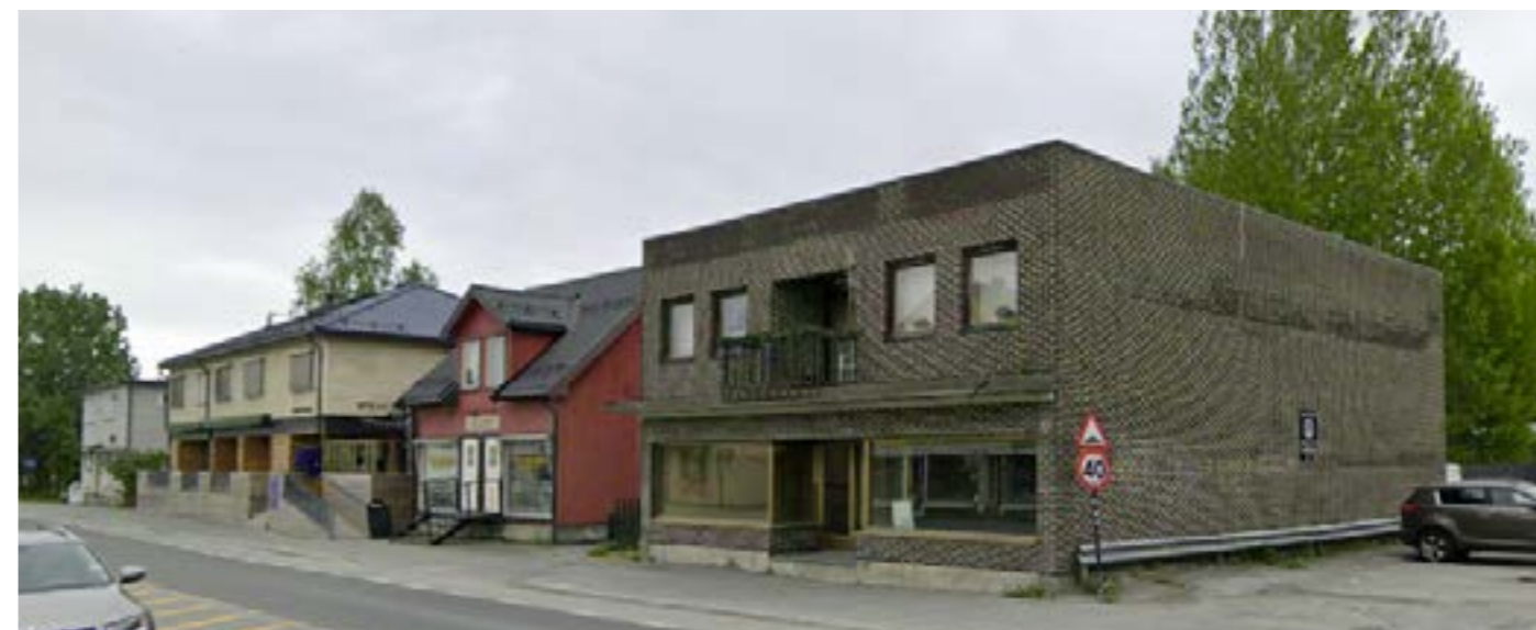
Storgata 38 (nærmest), 40, 42 og 44 sett fra sør. (Google, 2025)
