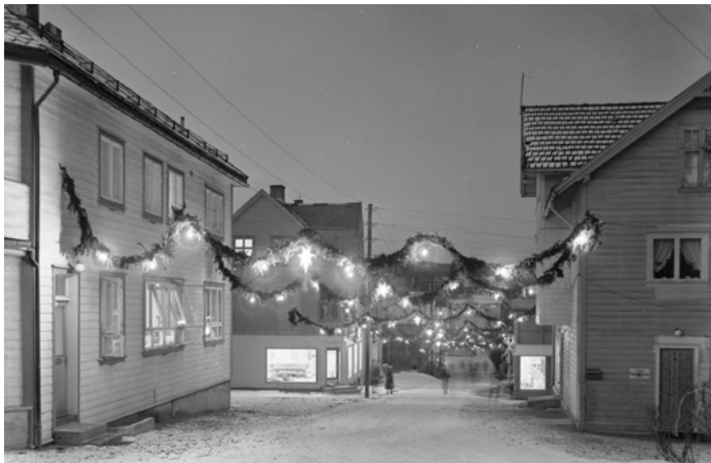
Julegate i Østvollvegen. Til venstre er kommunehuset som nå er revet og erstattet med Greina borettslag. (Digitalmuseet, 1957)
