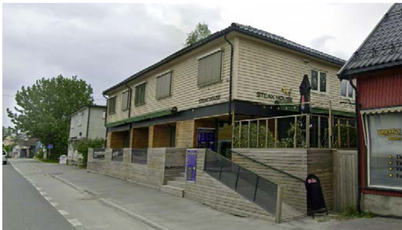
Storgata 42 – gbnr. 14/46. byggeår 1936/ 1937. 1. etg. ombygget til restaurant 2022. Leiligheter i 2. etasje. (Google, 2025)
