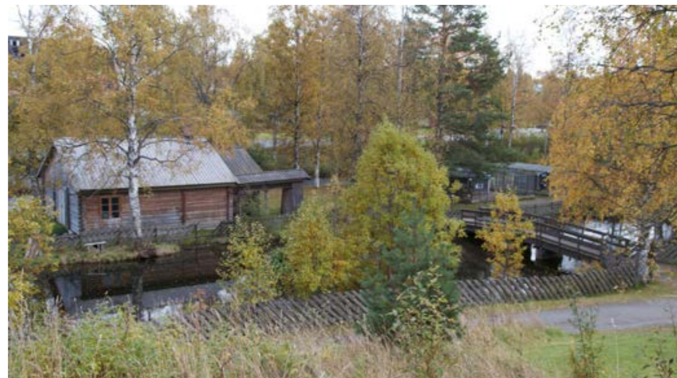
Rekonstruksjon av Ljåsmie oppført i 2000. Bildet viser vestsiden av smia og dammen. (Ree, 2012)
