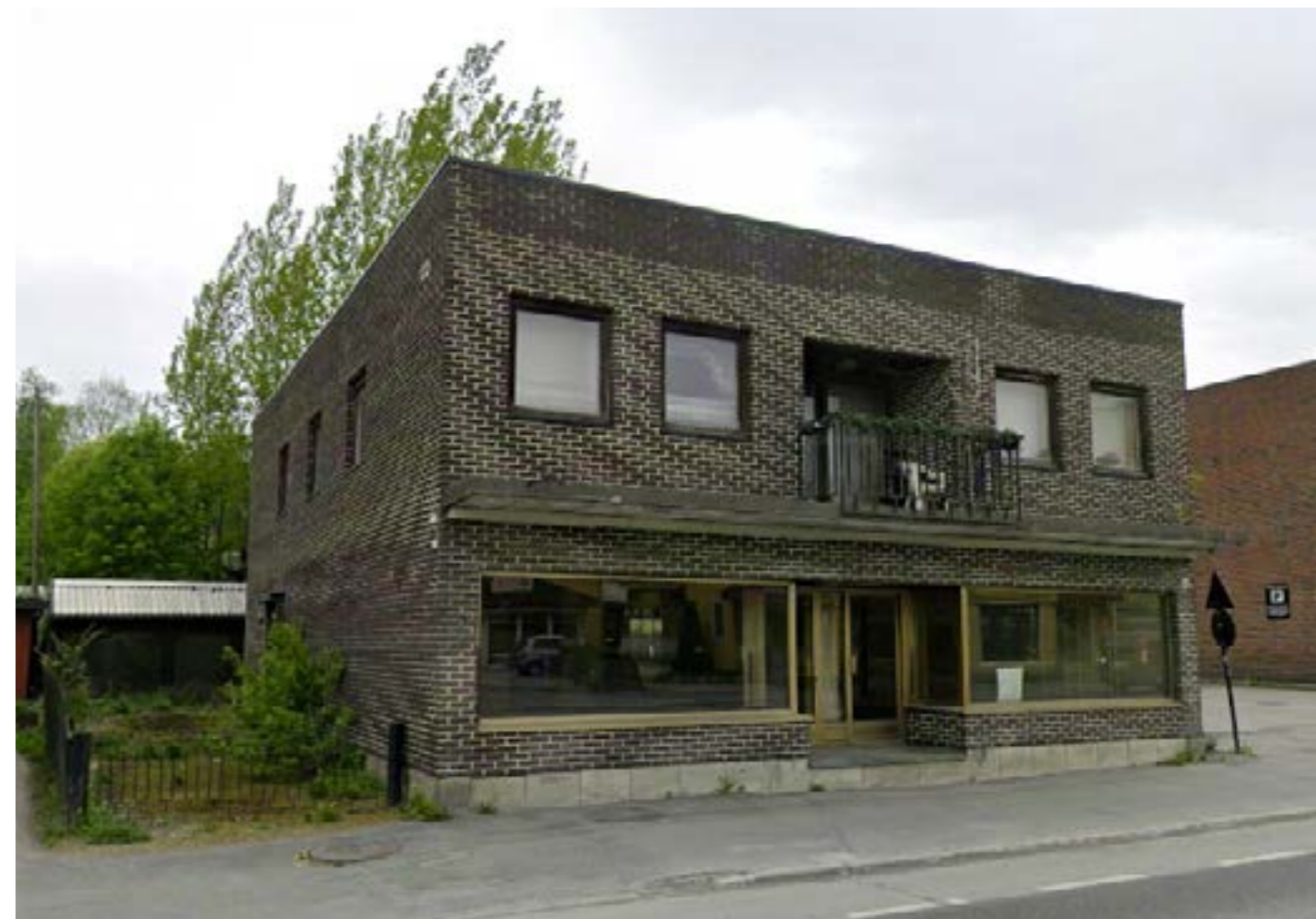
Storgata 38 - gbnr. 14/63. Bygget er sto ferdig i 1971. Bygget står tomt i dag. (Google, 2025)
