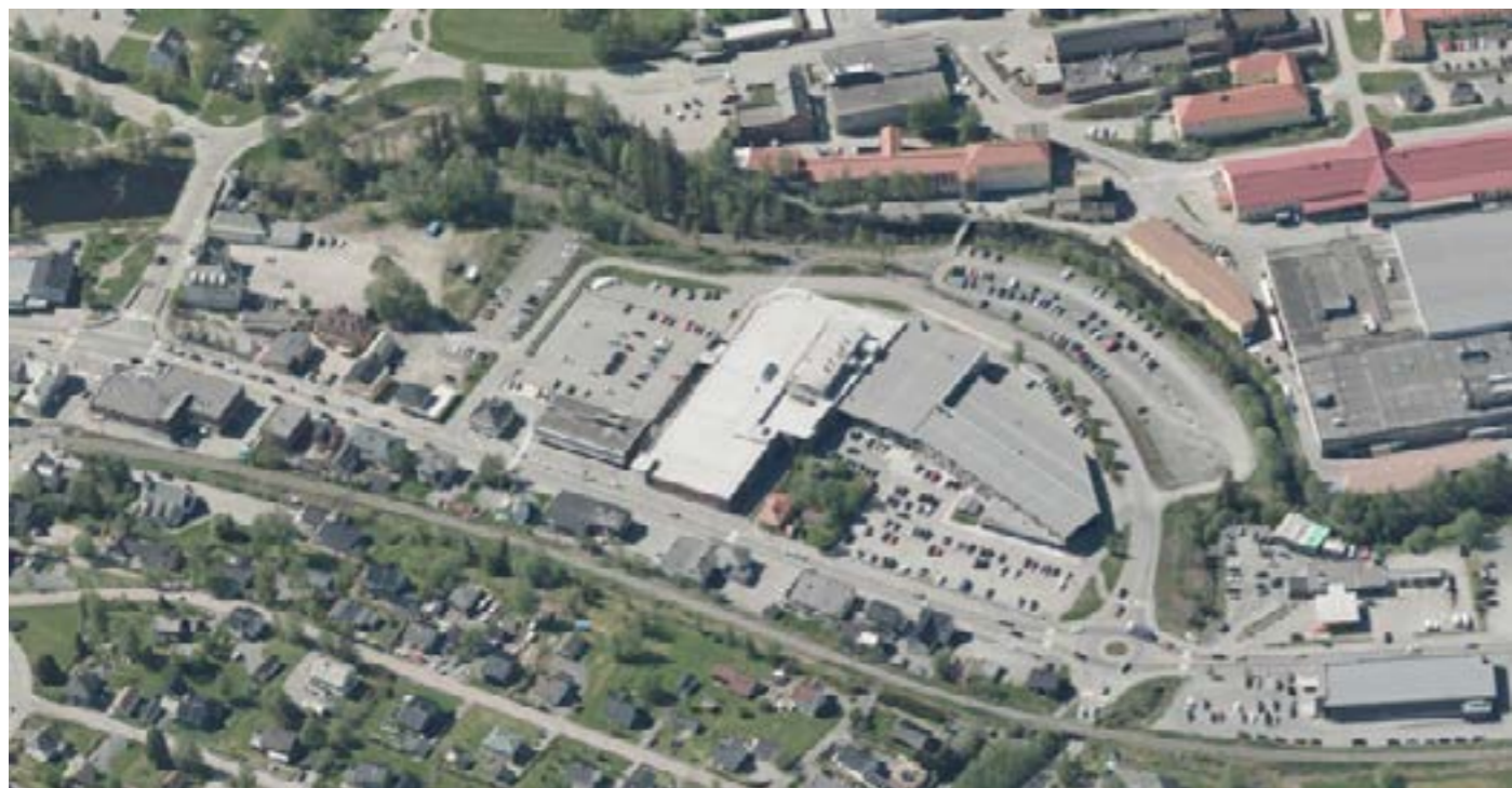
Det er mye grå arealer i planområdet. Rundt Rundkjøringa mangler det bebyggelse og vegger som definerer gata tydeligere. (Vestre Toten kommune, 2020)
