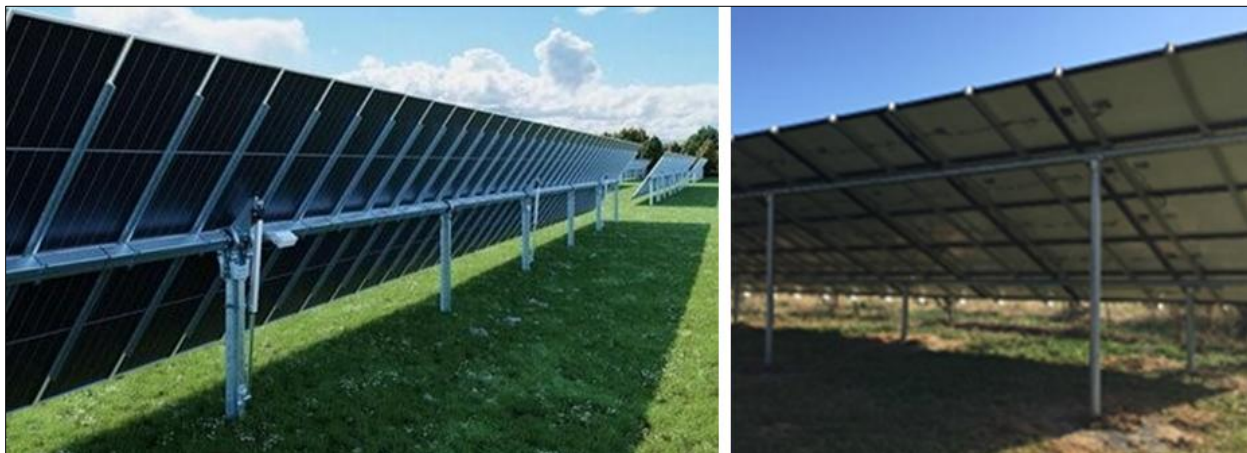
Figur 1-6: Eksempel på solcellemoduler med én-akse sporing (venstre) og solcellemoduler med fast montasjevinkel (høyre) (Solar, Trina) (Suncityenergy, u.d.).
