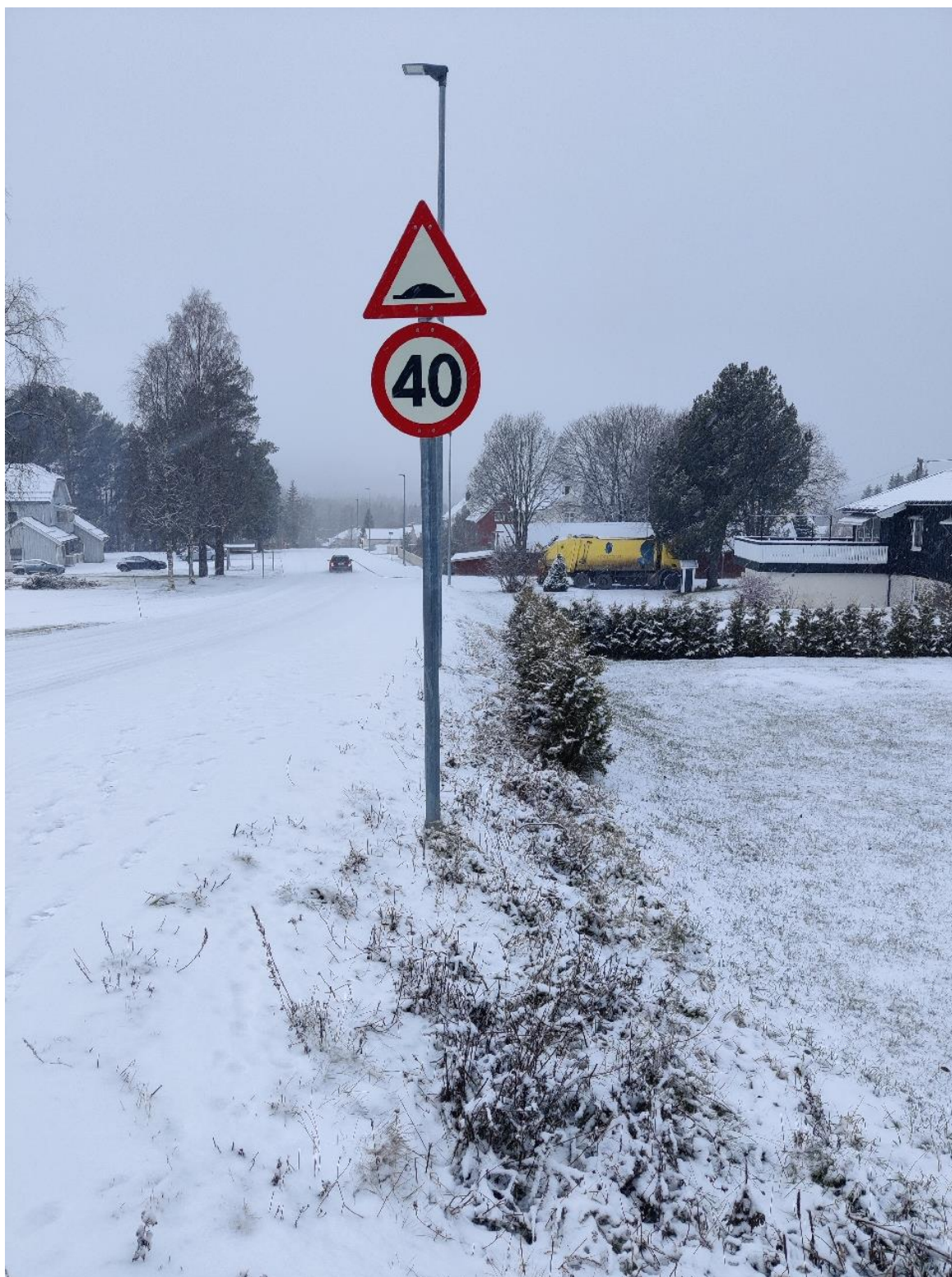
Figur 19 Mangel på grøft. Vann vil renne langs veien eller inn i hager. Bildet er tatt mot sørvest og er knyttet til interessepunkt 4.
