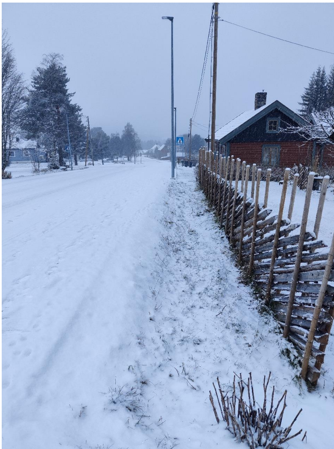
Figur 20 Grøft med kapasitet til å lede vannet. Bildet er tatt mot vest/sørvest og er knyttet til interessepunkt 9.
