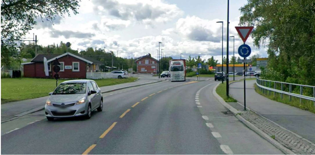
Figur 4-46 Gang- og sykkelvegtilbud i Storgata. Skysstasjon midt i bildet. Kilde: Google maps
