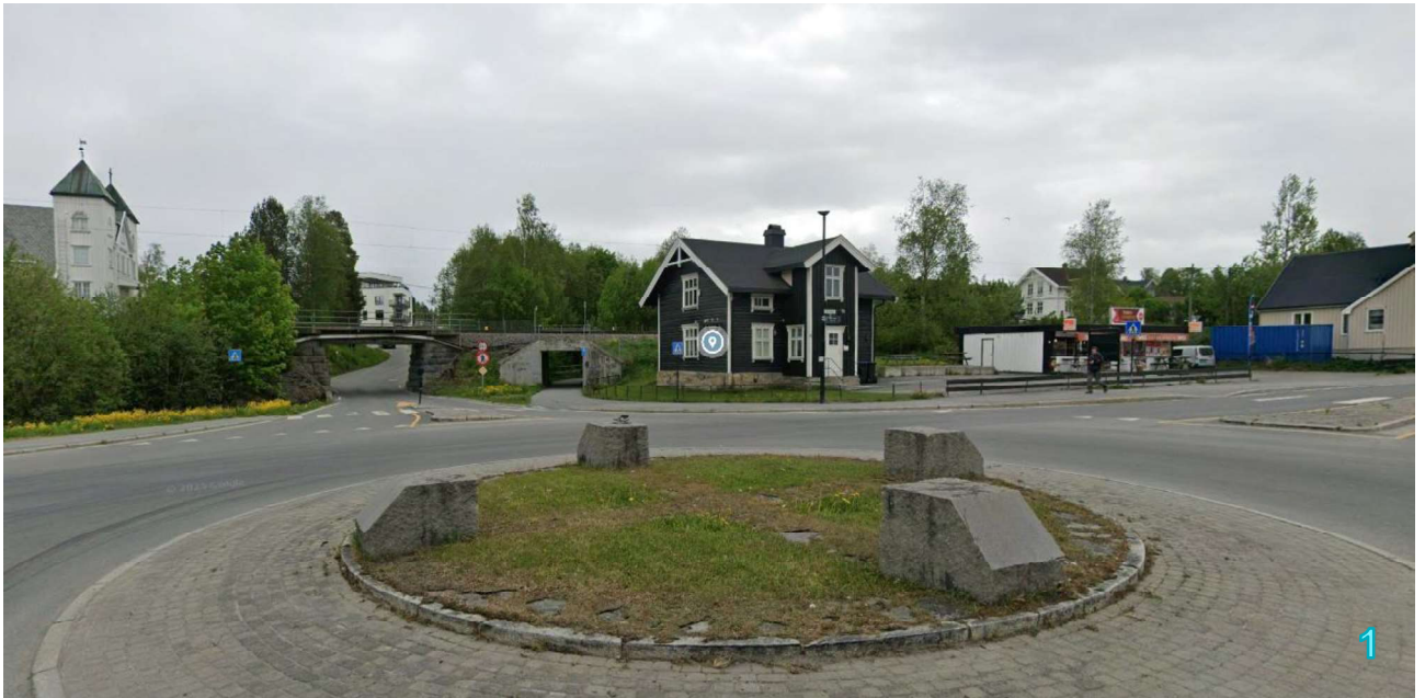
Figur 4-27 Undergang under Gjøvikbanen i Øverbyvegen. Sett mot øst fra Storgata. Kilde: Google maps
