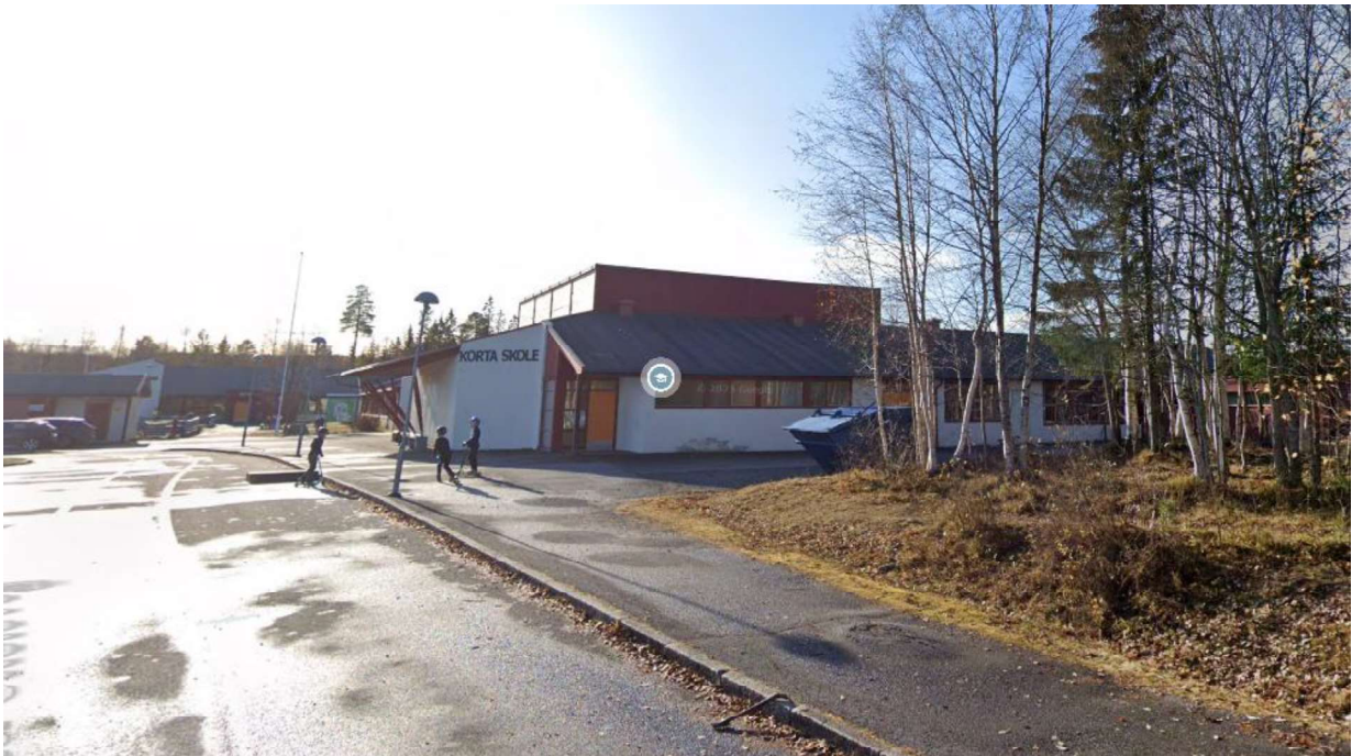
Figur 4-35 Fortau fram til skolen. Kilde: Google maps
