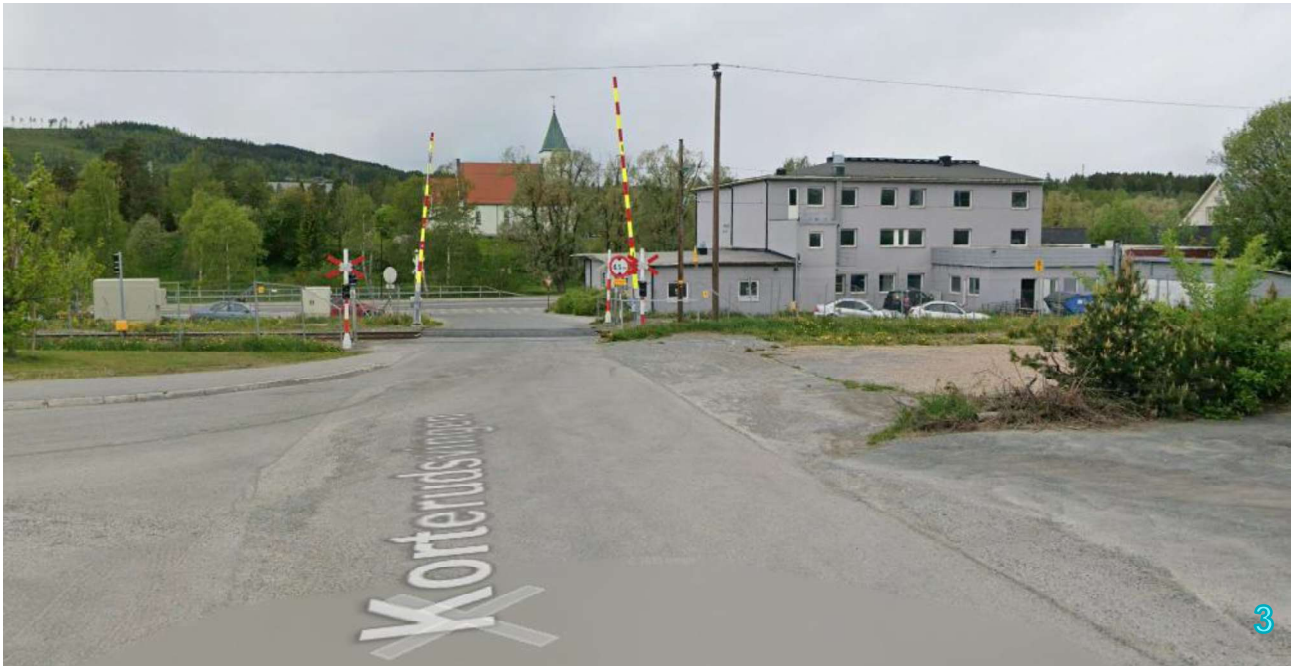
Figur 4-29 Jernbaneovergang i Korterudsvingen sett mot Storgata i vest. Kilde: Google maps
