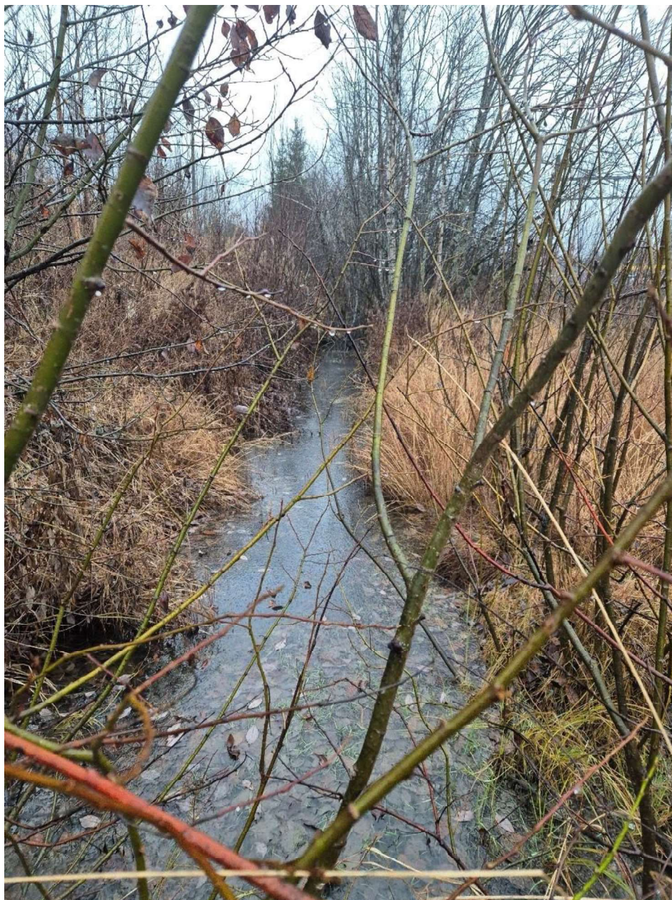
Figur 25: Naturlig søkk med stående vann i sammenheng med utløp av overvannsledning. Bildet er tatt sørover, et stykke nord for overvannsutløpet.
