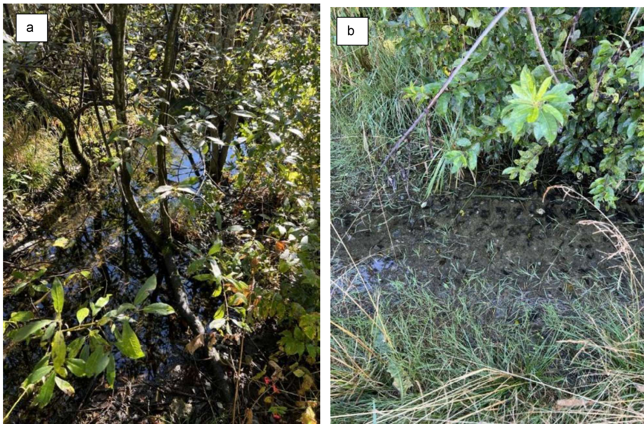
Figur 11 Stående vann observert i et flatt og lavtliggende område vest i planområdet, sør for Sagatunet og ned mot jernbanen. Observasjonen indikerer dårlig drenerende masser i området. Se også Figur 25.
