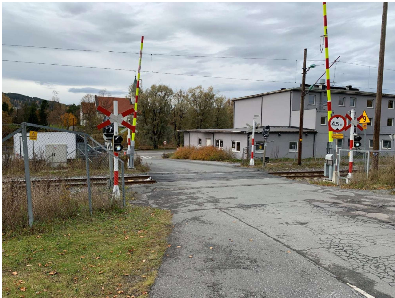
Figur 1-6: Planovergangen i Korterudsvingen sett mot vest
