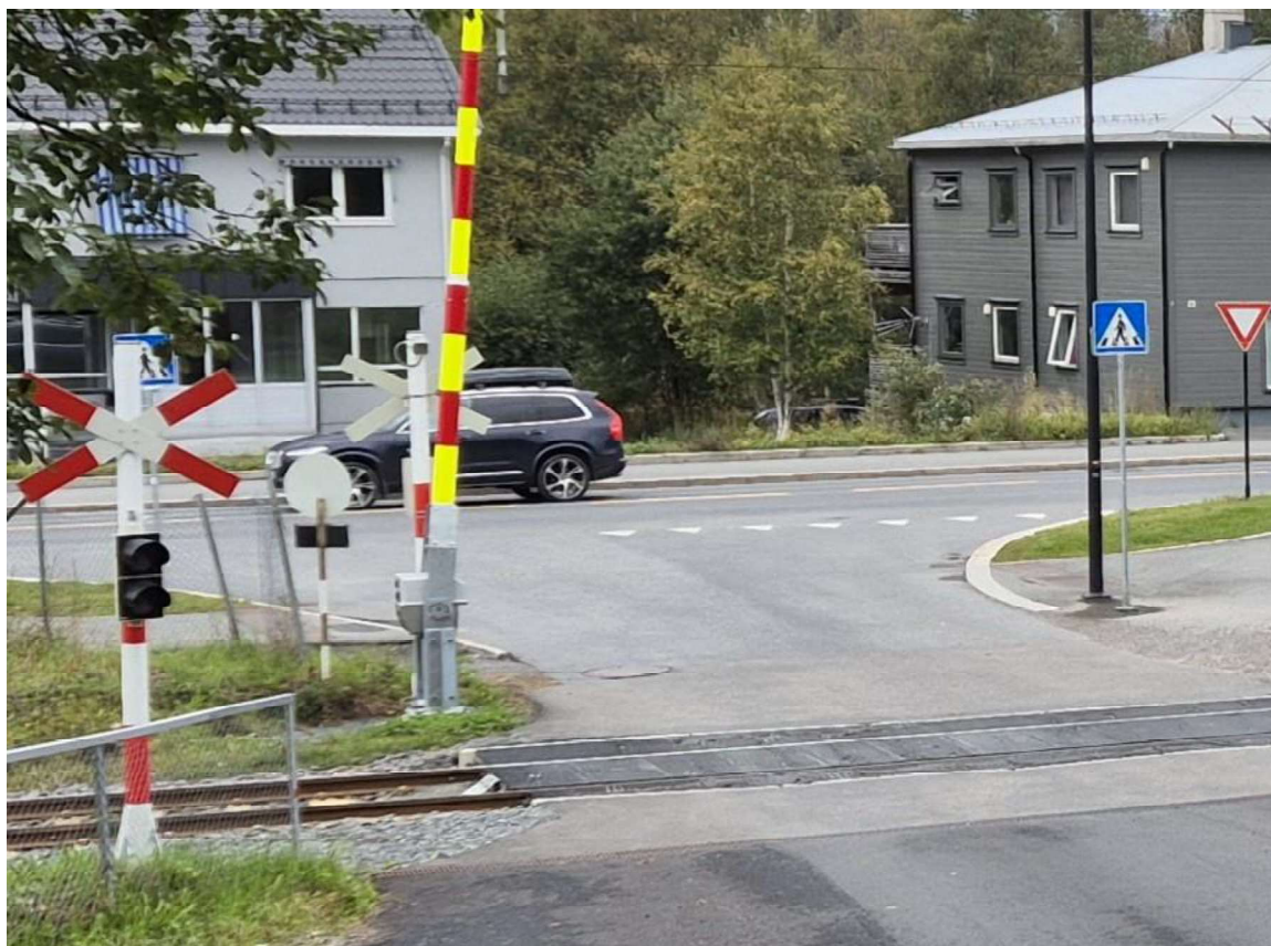
Figur 1-13: Gangfelt på østsiden av planovergangen i Løvåsbakken
