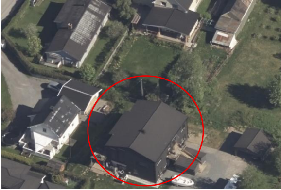
Fig. 11 Vinkelvegen på Raufoss, grunnflate og volum Avviker fra nærområdet, virker dominerende
